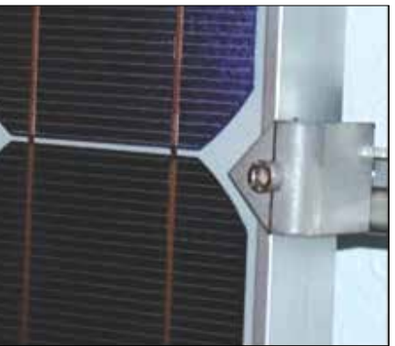
شکل ۴- ساخت چهارچوب پیل‌های خورشیدی از جنس فولاد رنگ‌نزن دوفازی کم‌آلیاژ.
